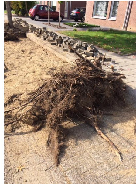
Figuur 14. Verwijdering van boomwortels onder elementenverharding in gemeente Meerssen.
