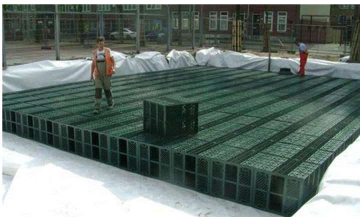
Figuur 11. Een voorbeeld vanuit een andere gemeente; aanleg infiltratiekoffers onder parkeerplaats (bron: Waterwindow.nl)
